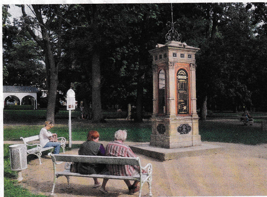
Opravený sloupek ve Františkových Lázních
